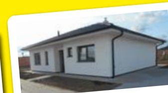
Novostavba RD - Galanta 158 500€
